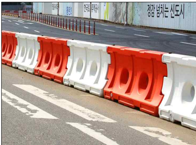
PE 방호벽(중앙선에 설치)
